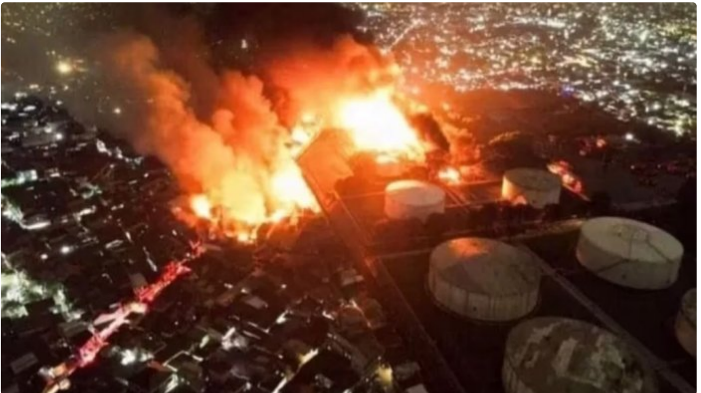
Depo Pertamina Plumpang Meledak
